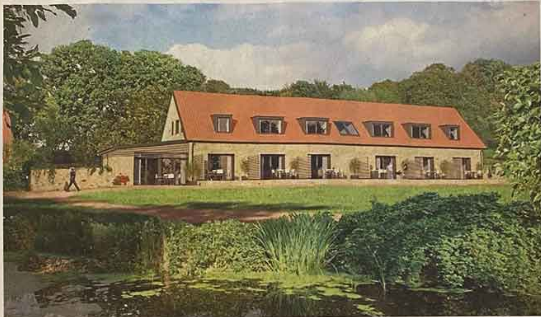
So soll es im August aussehen: Im ehemaligen Stallgebäude entstehen derzeit neun Ferienappartements.
